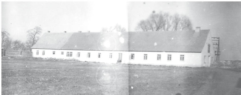
Internat męski w budynku po byłej owczarni.
